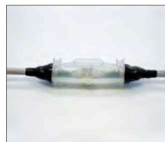
1.- Conexionar y cerrar carcasa
