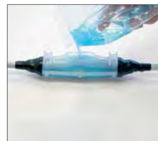
3.- Rellenar torpedo Verter el contenido del compuesto sellante hasta cubrir por completo la entrada del torpedo.
