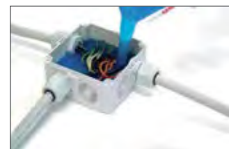
3.- Rellenar la caja Verter el contenido del compuesto sellante hasta cubrir por completo la caja.
